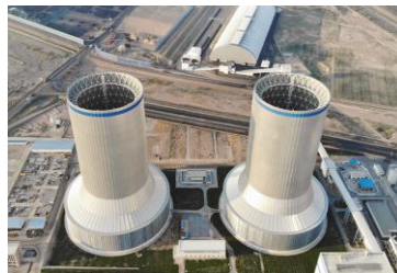
(图为智能化全钢结构间接空冷系统)
