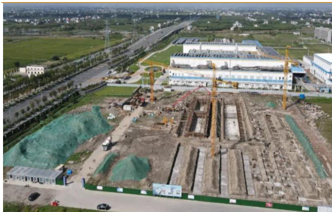
图 86：高性能电子铜箔二期项目施工
