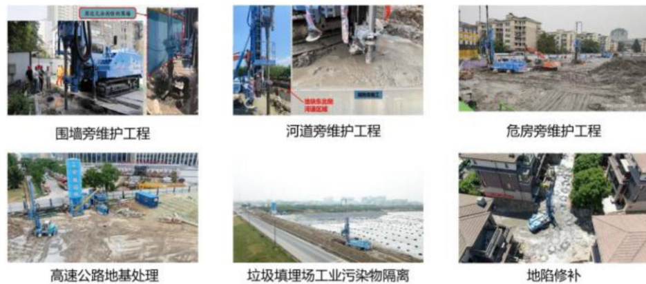
图 29：不同场景的地下维修维护工程
