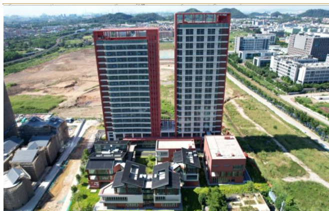
图 32：南方传媒中心现场图片
