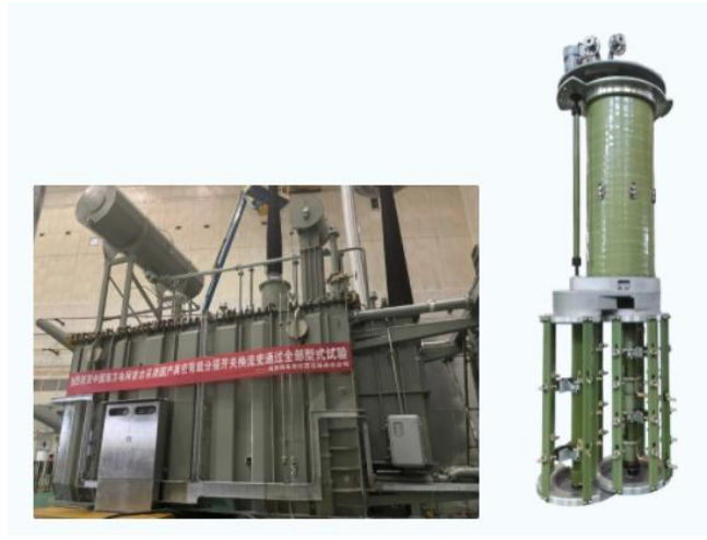
图 17：华明特高压换流变有载分接开关通过国家级鉴定
