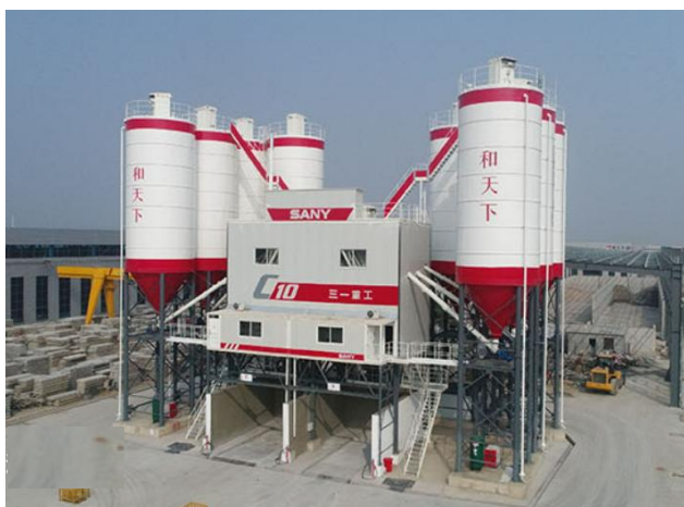
图1：混凝土搅拌站
