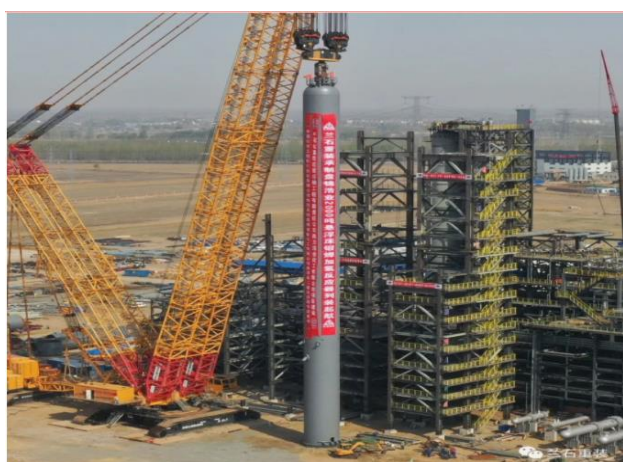
图 14: 加氢反应器(锻焊式)
