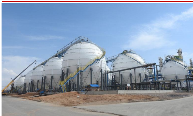
图 23：神华宁煤球罐工程
