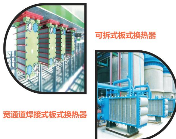
图 27：公司典型板式换热器产品
