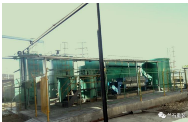
图 31：污水处理厂扩容增量提标改造项目
