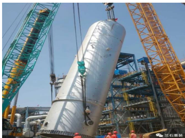
图 15: 加氢反应器(板焊式)
