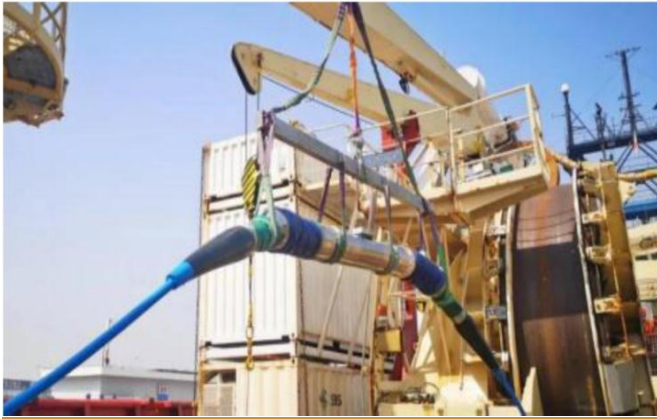
图 54: 全球首个 16 纤对中继海底光缆系统
