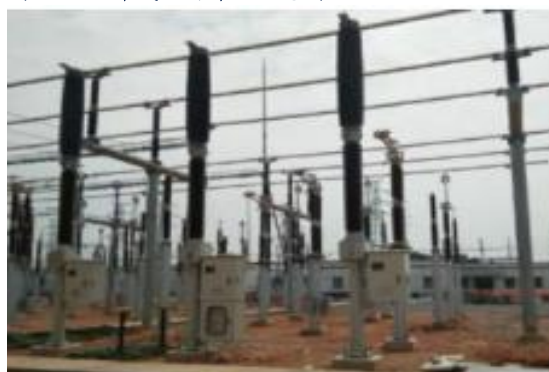
图 92: 敞开式隔离开关示意图
