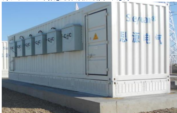
图 97: SVG (动态无功补偿设备) 示意图
