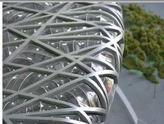
图5：“鸟巢”应用了大量的 ETFE 材料
