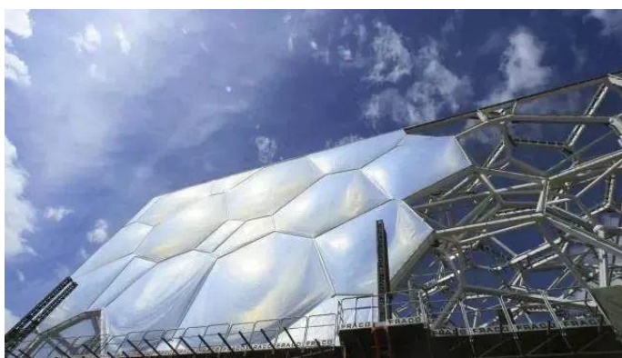
图4：“水立方”是我国最大的 ETFE 建筑
