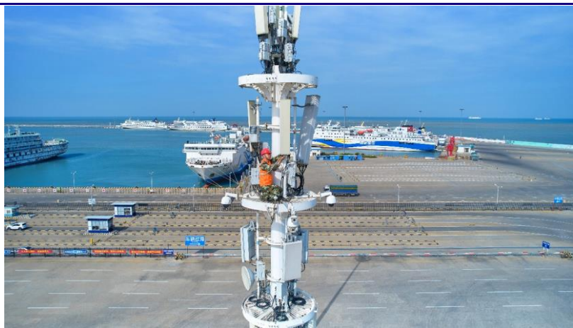
图 7. 建设海航 5G 基站，打通海陆通信“最后一公里”
