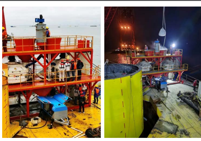
图 24：福能三川平海湾 F 区海上风电场灌浆施工
