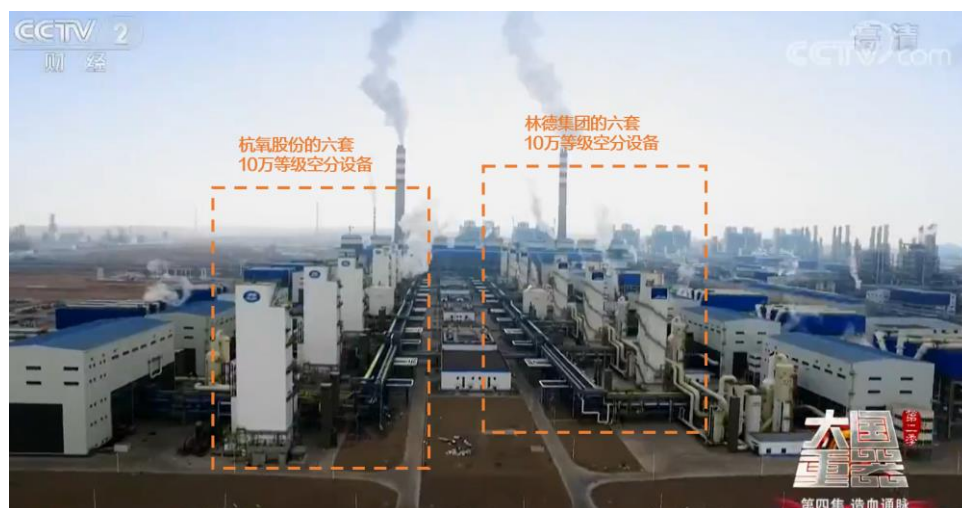
图 49：神华宁煤项目中杭氧和林德的空分设备
