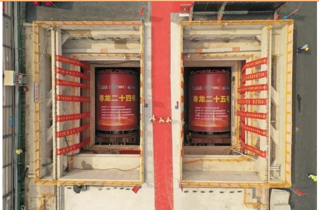
图 39: 广州地铁十四号线二期项目
