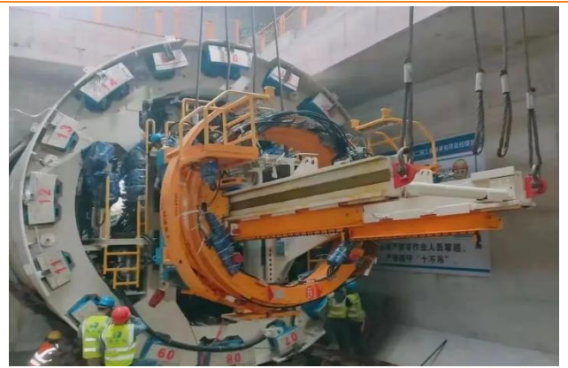
图 40: 广州地铁十四号线二期项目
