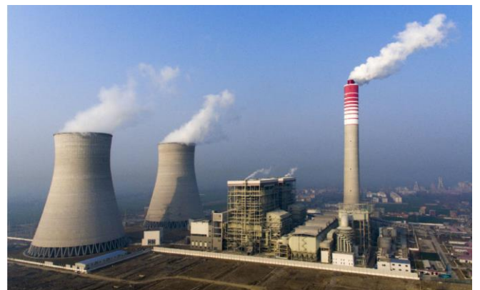
图16：利辛电厂安全稳定运营多年
