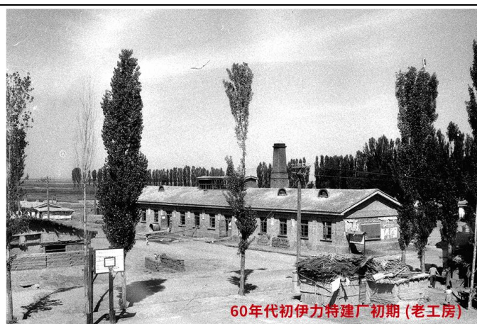
图 2：60 年代建厂初期（老工房）
