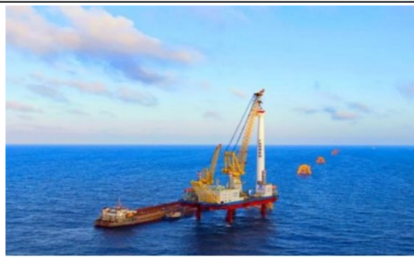
图23：“华电稳强”号海上风电作业平台
