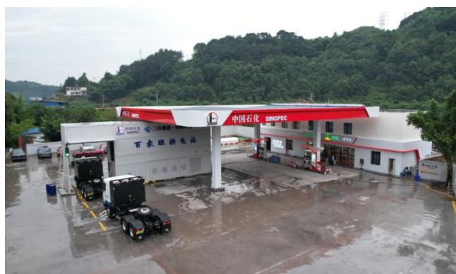
图32：中石化百家旺综合加能站
