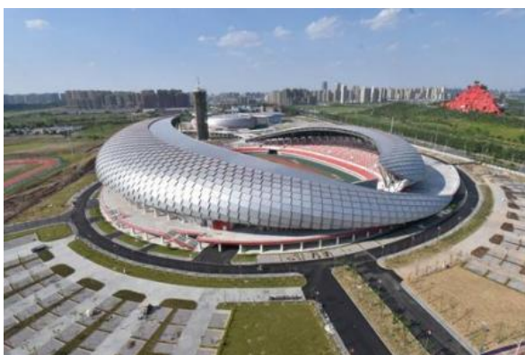
图 35：蚌埠市体育中心（圆形屋顶为铜铟镓硒电池组件）
