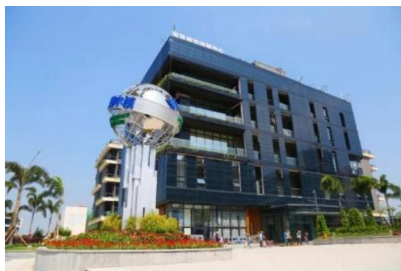
图 36：潼湖科技小镇（外立面采用铜铟镓硒电池组件）
