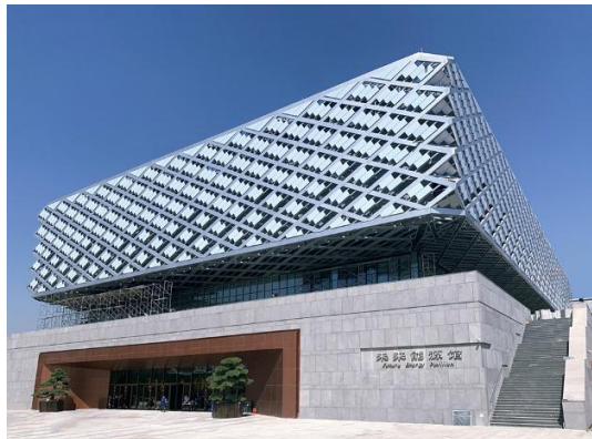
图 40：大同未来能源馆（外立面采用仿铝材型碲化镉薄膜组件）
