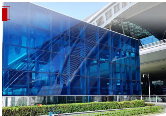
图 37：成都双流机场航站楼（L1 通道采用碲化镉电池组件）
