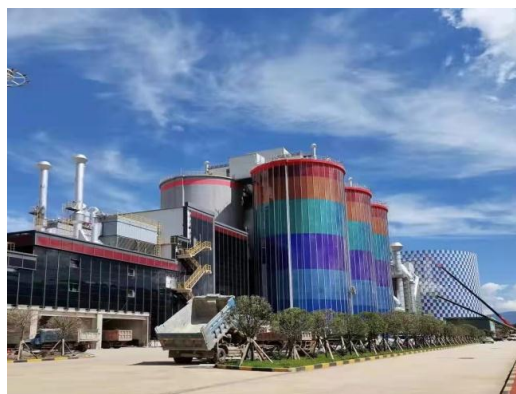
图 38：中建材丽江水泥厂（外立面选用碲化镉薄膜电池）
