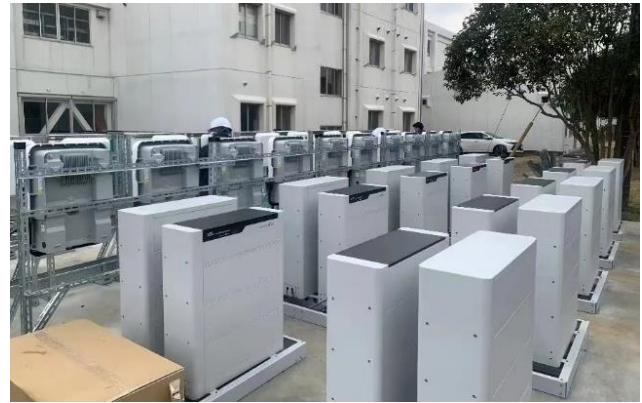
图 65 天合储能分布式储能设备
