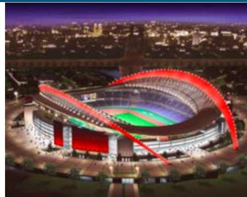
南京奥体中心（电线电缆业务）
