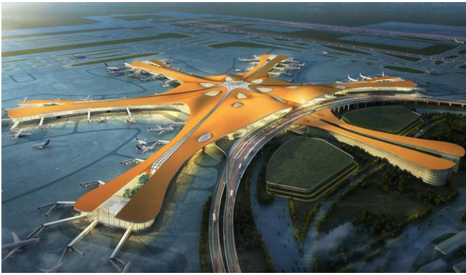
图 3：北京大兴国际机场航站楼项目
