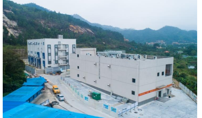
图 26：多端交直流混合柔性配网互联工程
