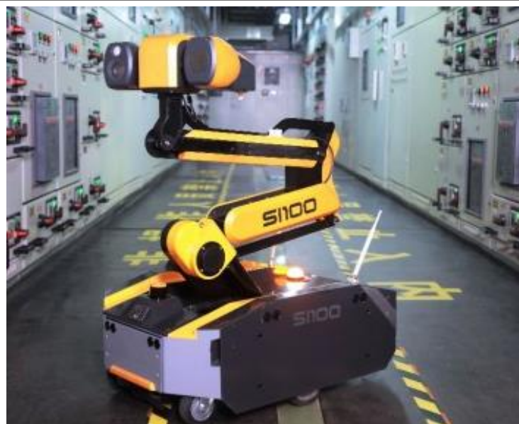
亿嘉和电力巡检机器人
