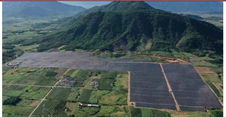
图 4: 公司产品—电站 (越南 Trung Son 35MW 光伏电站)
