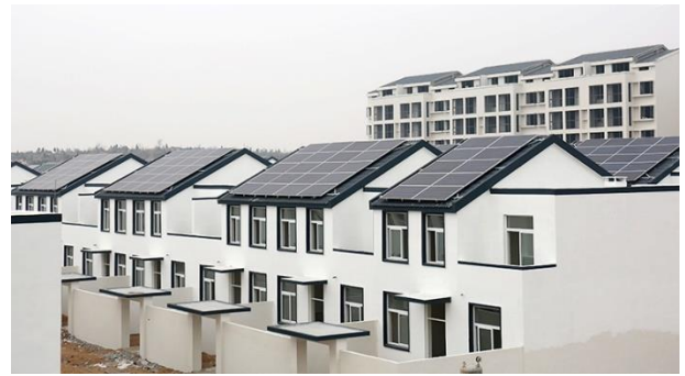
图 4：中国日照弓山村光伏发电项目
