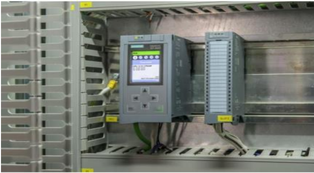
图17: 西门子 S7-1500 系列控制器等自动化设备覆盖整条试点线
