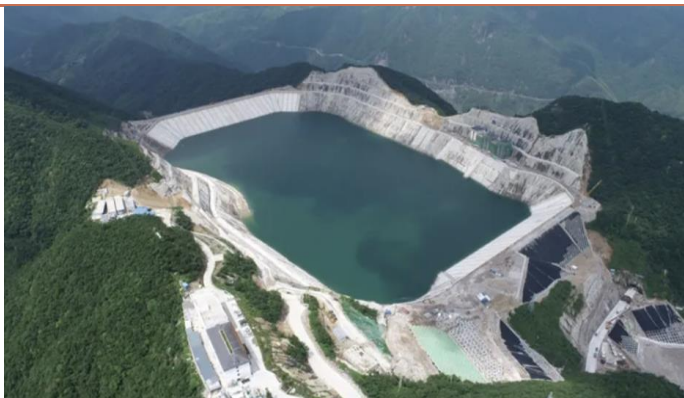
图 33 长龙山抽水蓄电站
