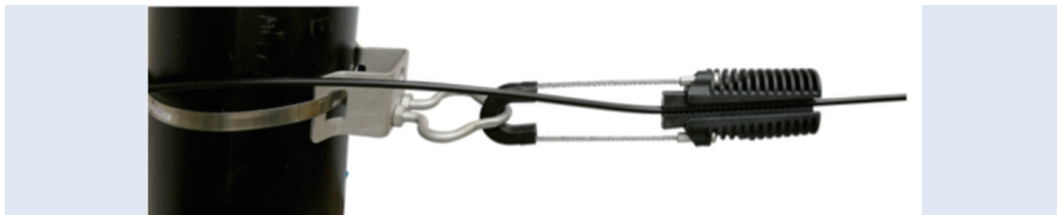
! 图 5-11 架空光缆锚固点（使用楔形耐张夹具） !
