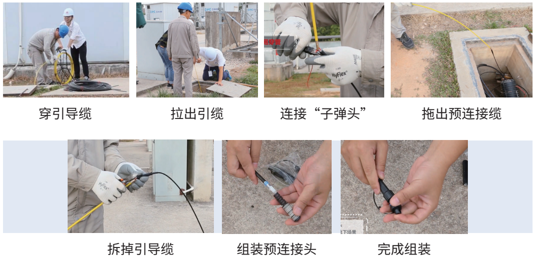
图 5-13 室外管道应用场景穿管施工过程
