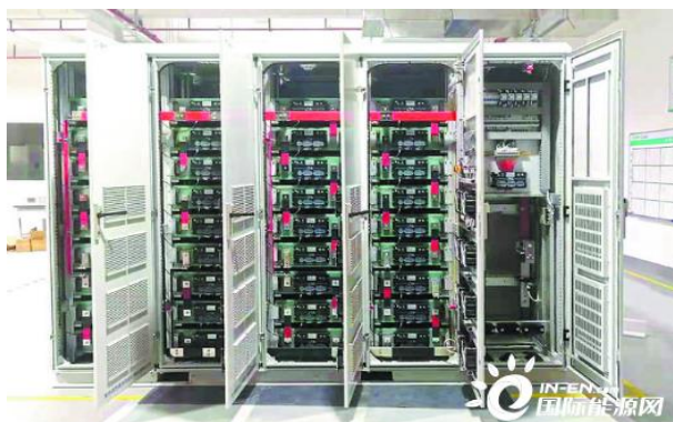
图35: 变电站用超级电容储能柜
