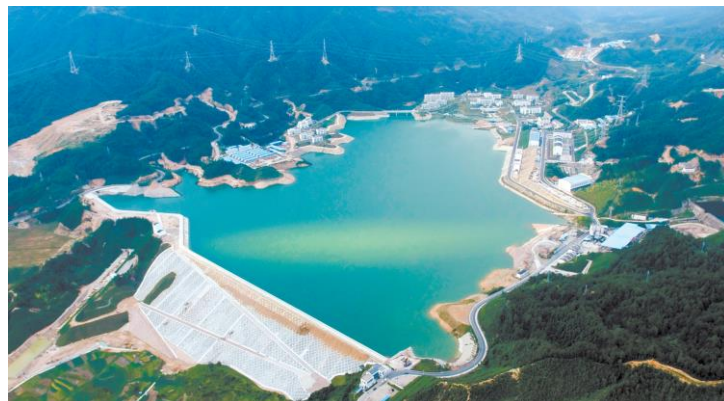
图：中国电建负责建设的安徽绩溪抽水蓄能电站
