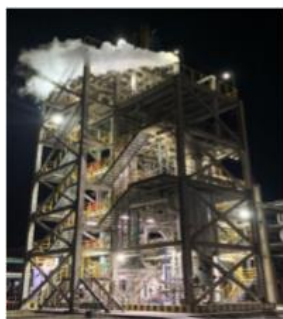
图 18：副产蒸汽氯化氢石墨合成系统
