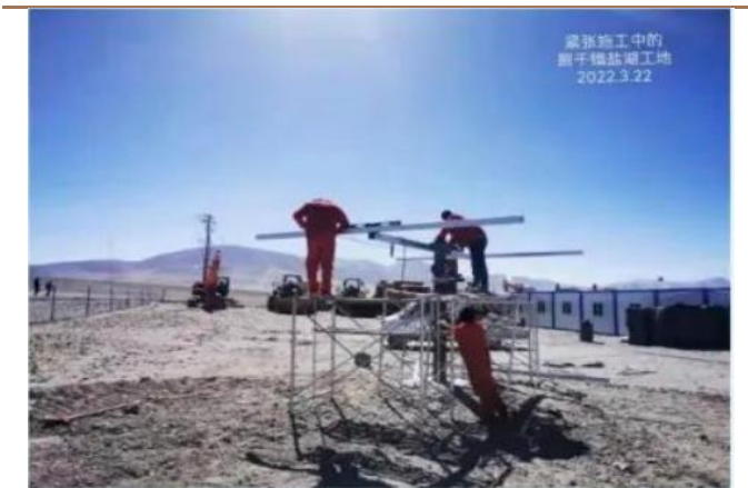
图 12：捌千错项目施工情况
