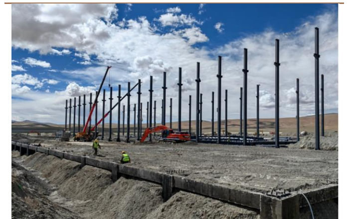
图 13：捌千错项目施工情况
