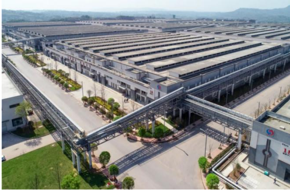
图 30：泸州老窖酿酒工程技改项目（一期）
