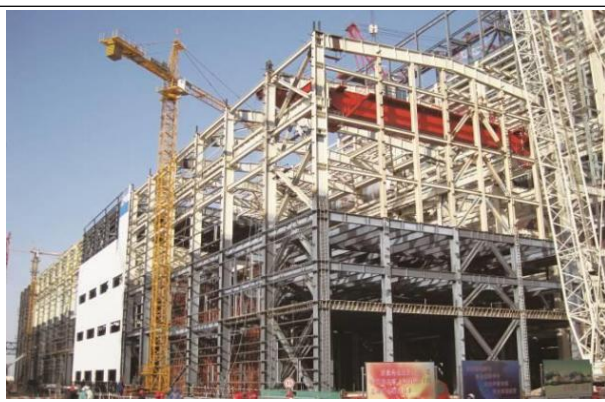
图10: 工业项目钢结构工程
