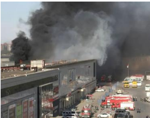
图 20：21 年北京市丰台区“4·16”储能电站火灾事故
