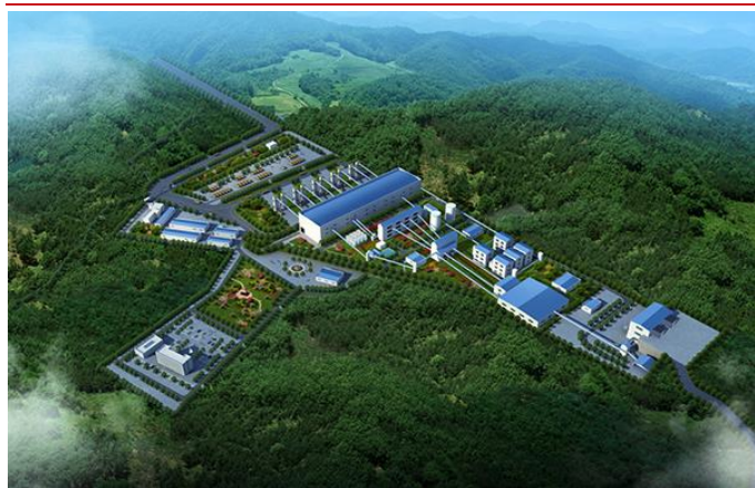
图表46：二道庄矿区修复治理配套的砂石骨料生产线
