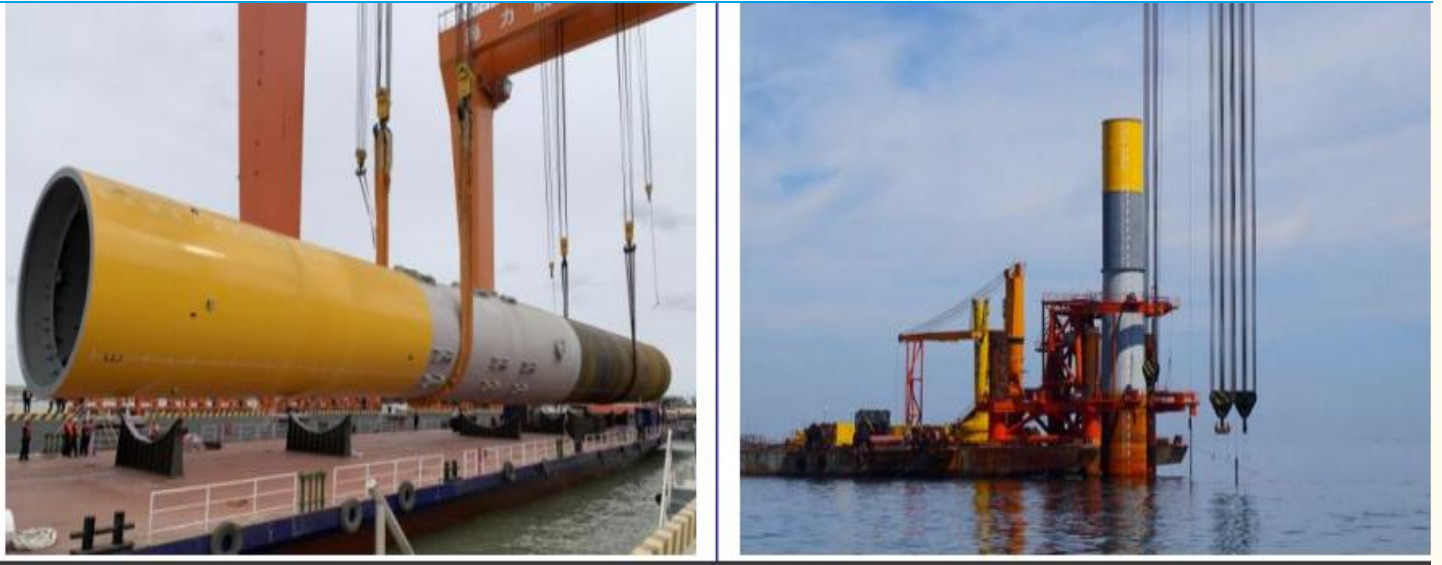
图表 12: 桩基是海上风电支撑基础
