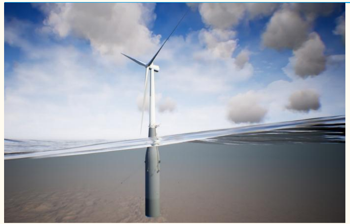
图表 14: 漂浮式（挪威 Hywind Tampen 海上风场）
