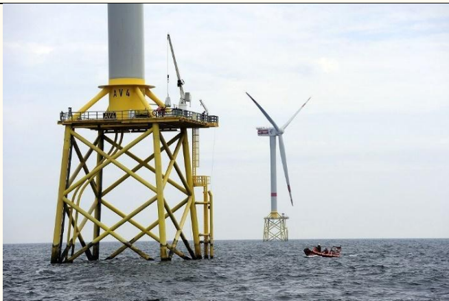
图表 13: 导管架基础（德国 Alpha Ventus 海上风场）
