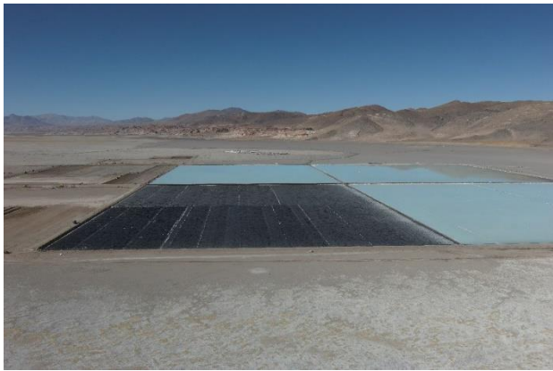
图 45: 项目一期首批 3 个沉淀池已经完工
