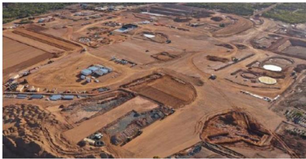
图 24: 矿山和选厂开始建设
