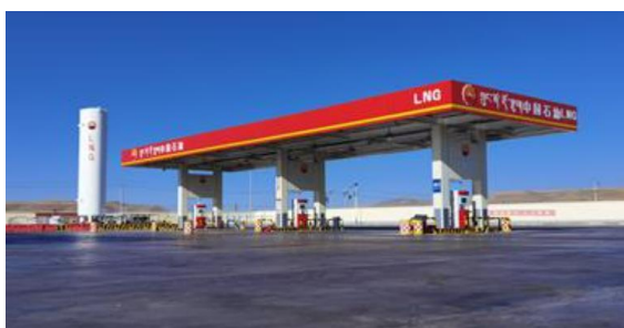
图 16：中石化青海 LNG 加注站
