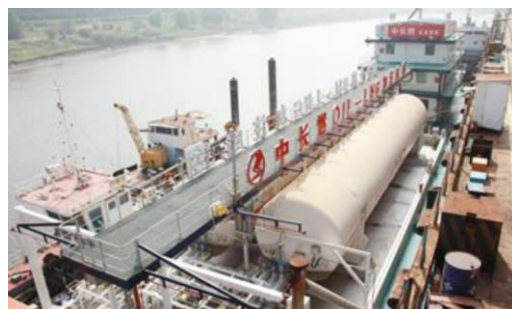
图 17：中长燃 LNG 水上加注站
