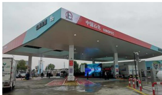
图 19： 上海第一座油氢合建站
