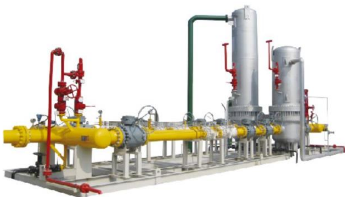
图6：燃气轮机需配套天然气场站设备供应燃料天然气
