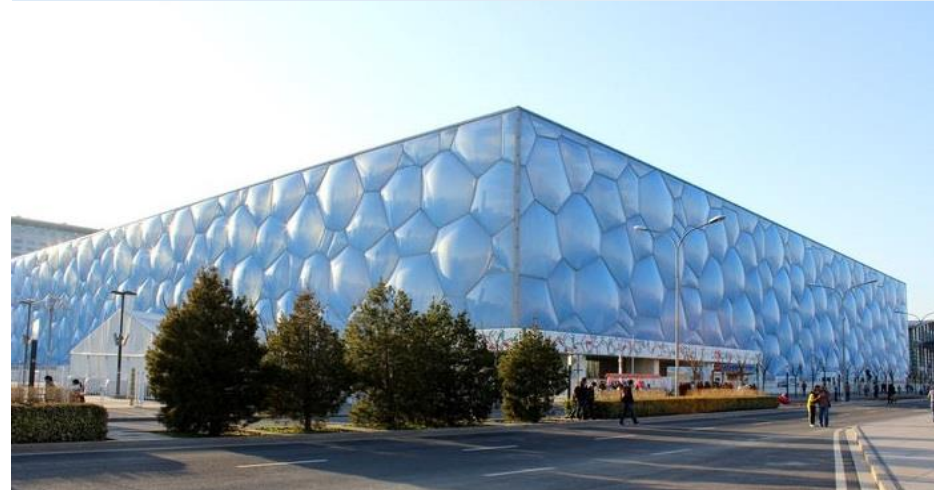
图：水立方中大量使用ETFE充气膜
