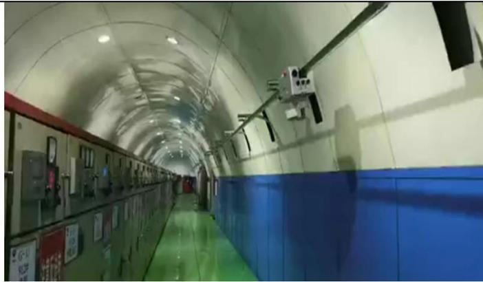
图 3-37 5G AI 机器人机电硐室无人巡检
