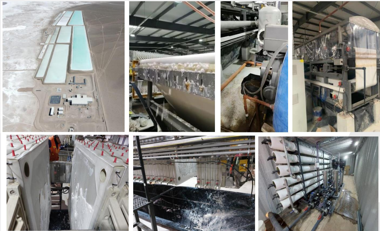
图20：Salar del Rincon项目2000吨/年碳酸锂项目即将投产
