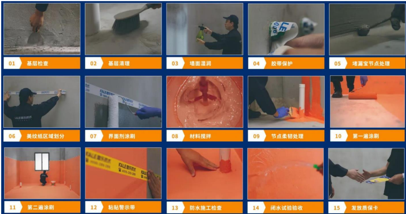
图37：伟星咖乐防水 15 步标准化施工流程
