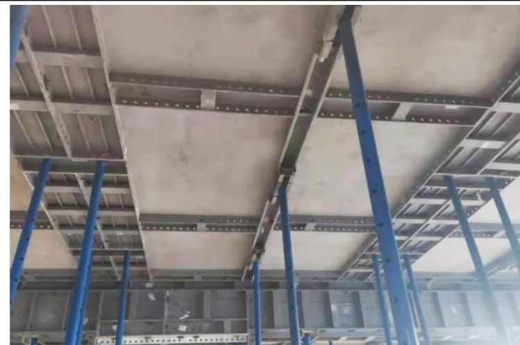
图：PC构件+铝模施工现场
