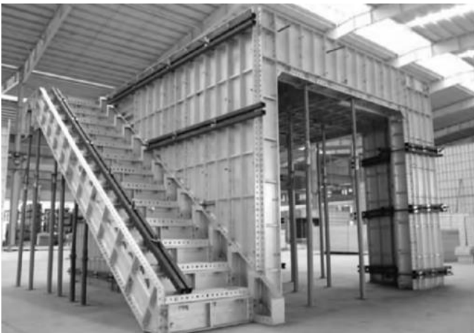
图：建筑铝模系统搭建实物图
