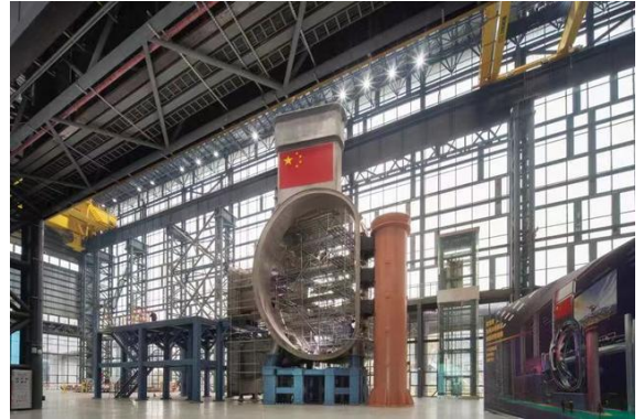
图29 聚变堆主机关键系统综合研究设施（CRAFT）建设进行中
