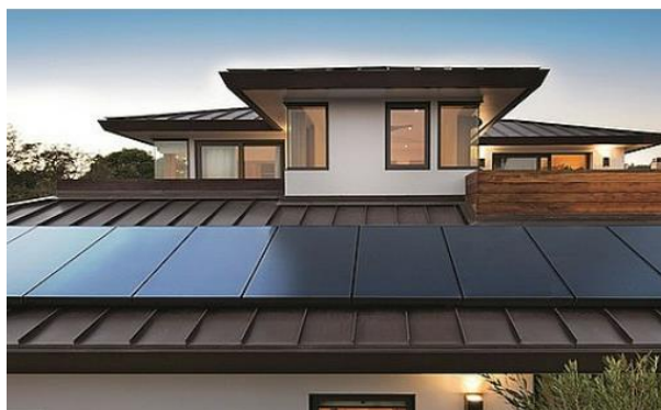
图 29：IBC 组件可装配到户用屋顶
