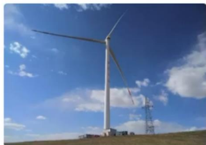
内蒙古红土井子风电场3.2MW风机并网实验
