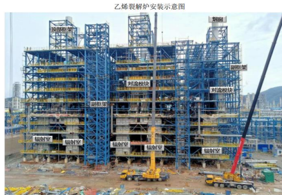
图表 15：乙烯裂解炉安装示意图
